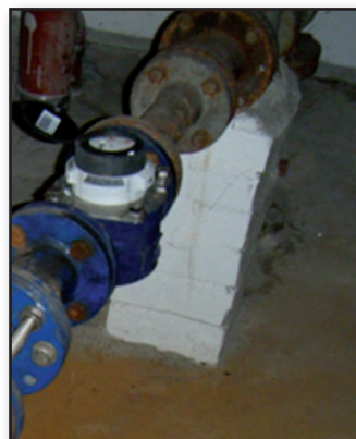
Trinkwasseranschluss
